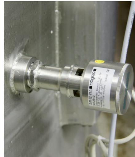
Hydrostatische Füllstand- und Prozessdruckmessung
