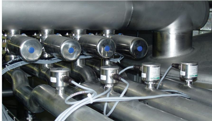
Durchflussmessung von demineralisiertem Wasser
