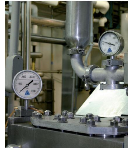
Manometer mit integriertem Transmitter für Homogenisatoren
