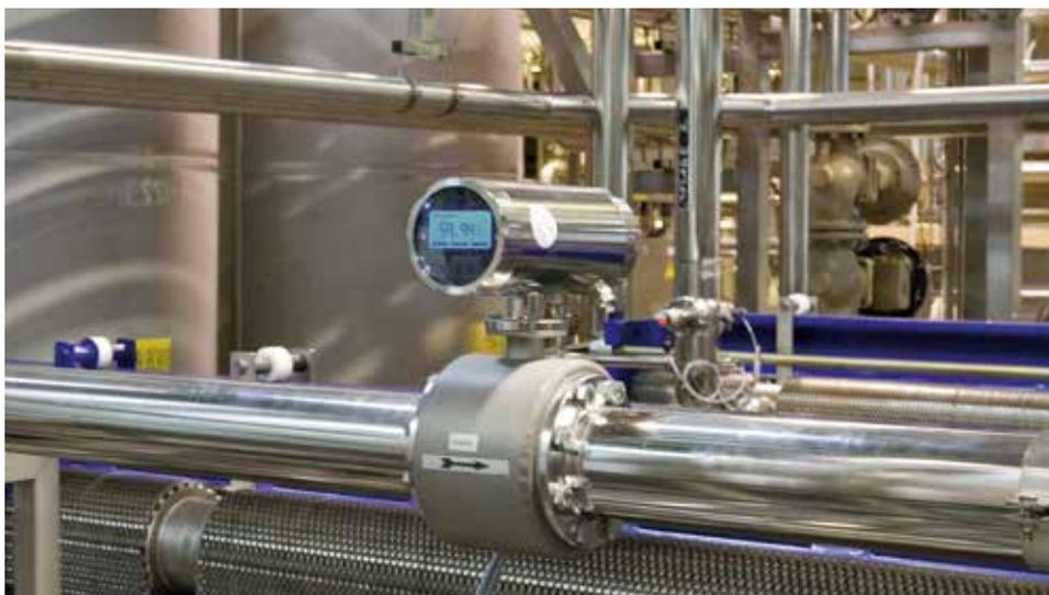
Измерение расхода деминерализованной воды
