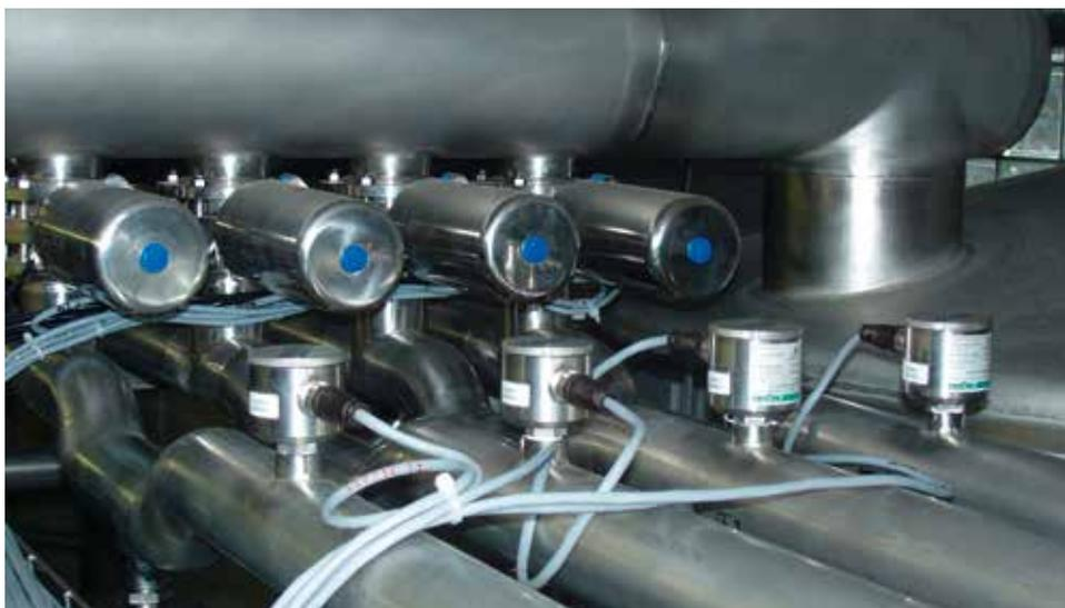
Измерение расхода деминерализованной воды
