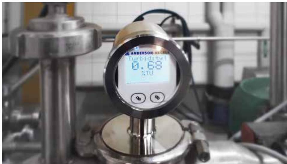
Датчик мутности (обратный рассеянный свет) в модульном исполнении
