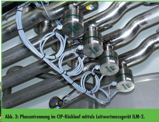
Abb. 3: Phasentrennung im CIP-Rücklauf mittels Leitwertmessgerät ILM-2.
