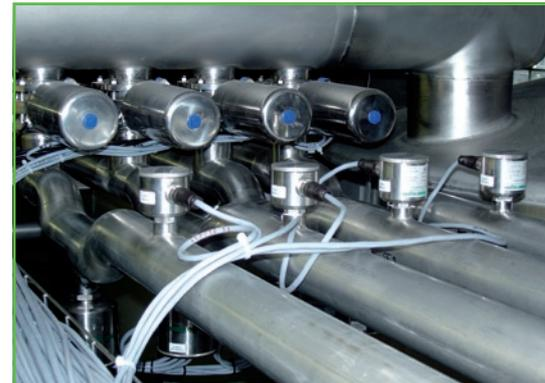
Abb. 4: Strömungswächter TYP FWA-141 eingebaut im Rücklauf zur Überwachung des CIP-Kreislaufes.
