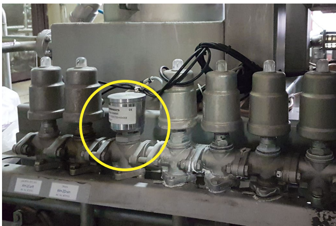
NCS-11 installé dans la brasserie en Inde du Sud
