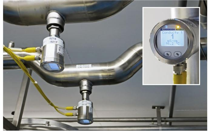
L'abaissement de chacun des trois lignes retours évite les bulles d'air et augmente la précision de mesure de l'ILM-4 installé sur la face inférieure de la conduite.
