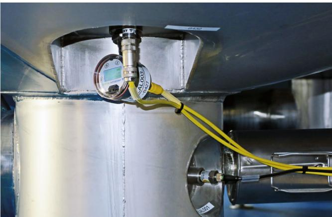
Mesure du volume, de la température et du niveau du contenu des cuves avec L3, TFP-161 et NCS-M-11
