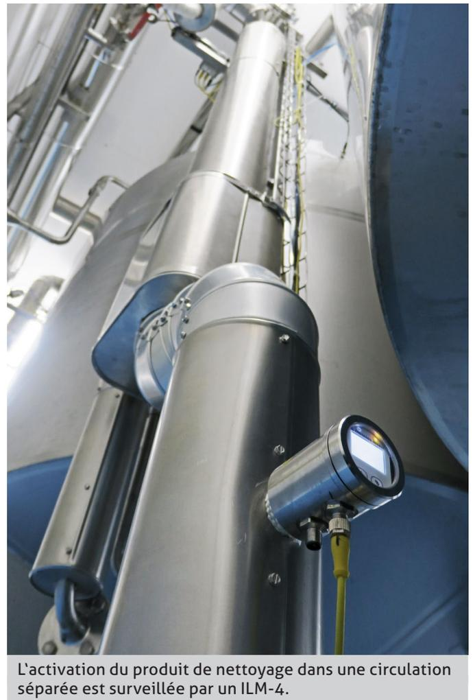
L'activation du produit de nettoyage dans une circulation séparée est surveillée par un ILM-4.
