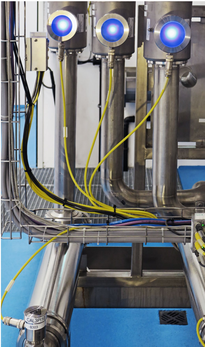
DAN-HH (unten) und FMQ (oben) überwachen Prozessdruck und Durchfluss nach den Pumpen der drei Reinigungslinien
