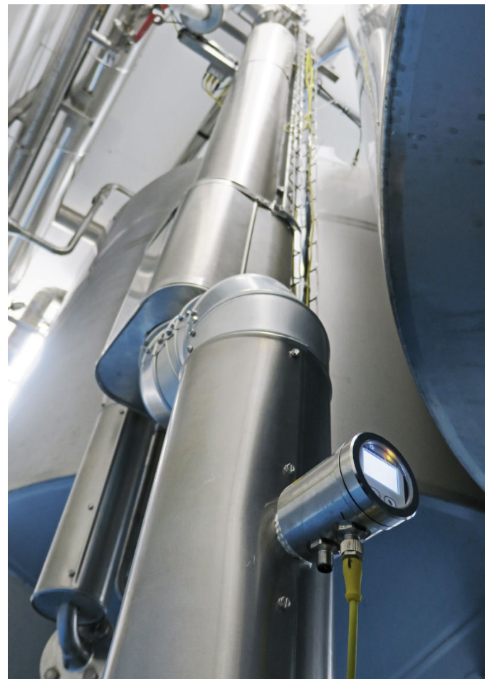
Das Aufschärfen des Reinigers in einer separaten Zirkulation wird mit einem ILM-4 überwacht
