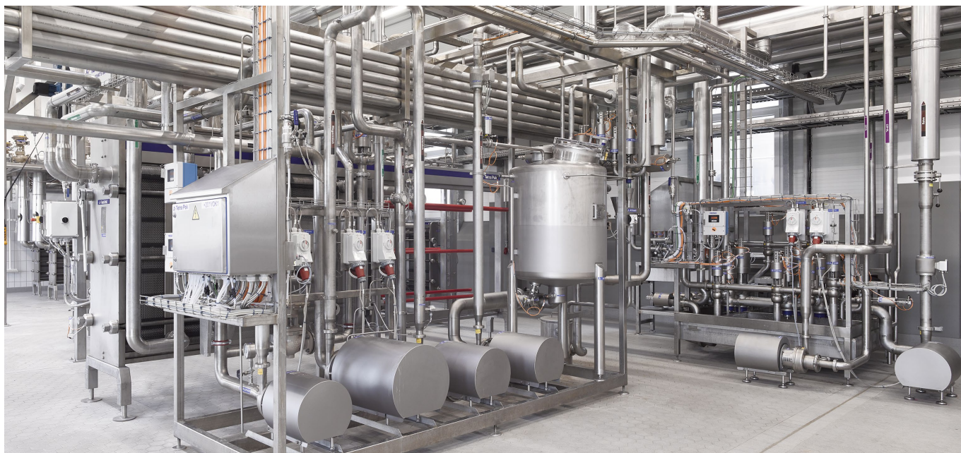
Centralny obszar linii produkcyjnej z rurowym wymiennikiem ciepła
