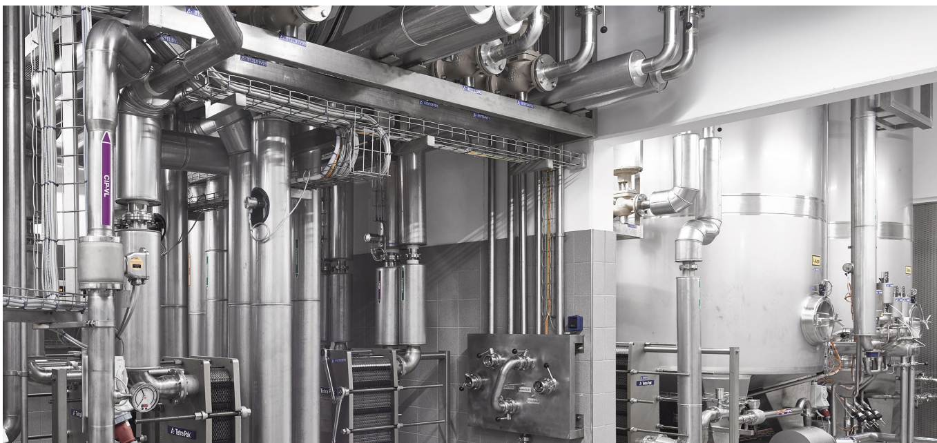
Stacja mycia CIP z aktywnym rozdziałem faz poprzez zastosowanie czujników
