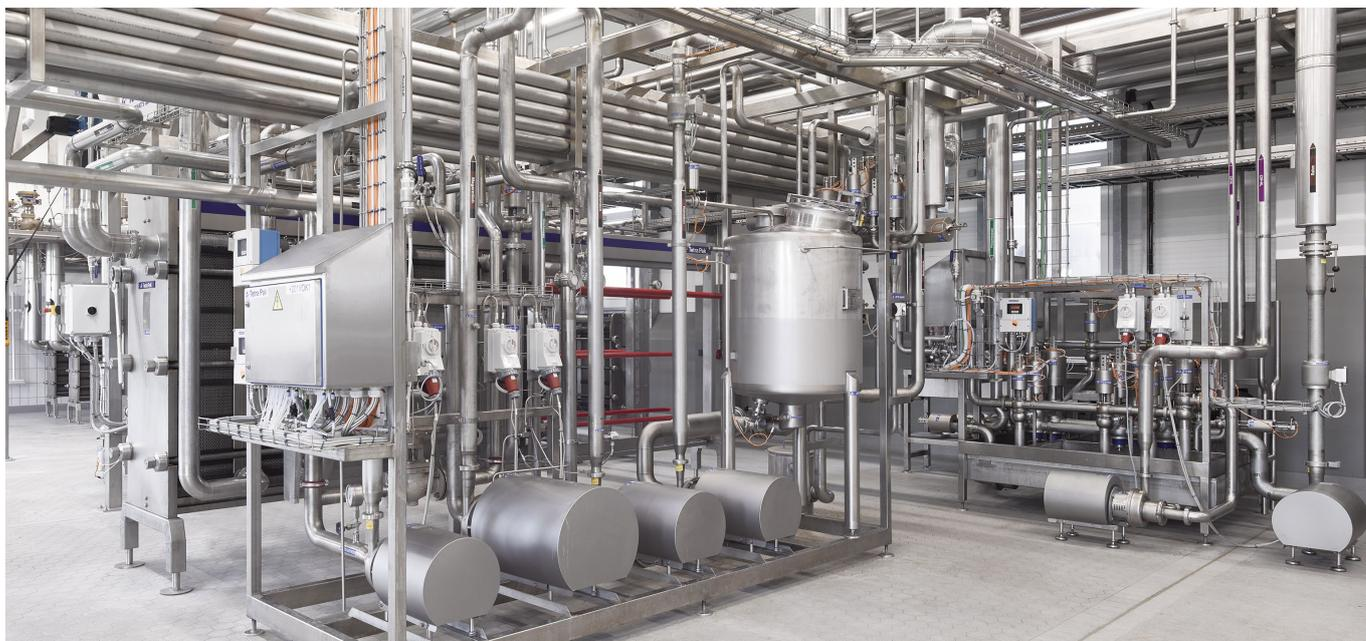
La partie centrale de l'usine avec des échangeurs de chaleur tubulaires
