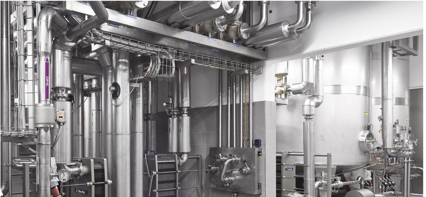
Le système NEP avec séparation de phase active grâce à la technologie des capteurs
