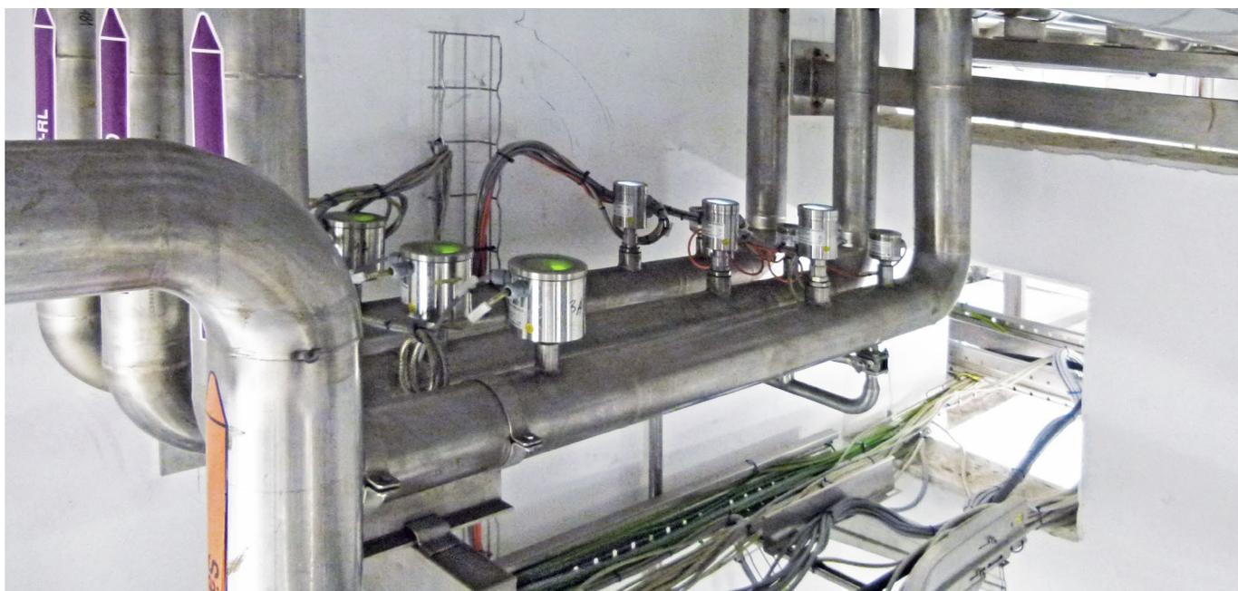
Capteurs ITM-3, ILM-4 et FWS pour une séparation de phase précise
