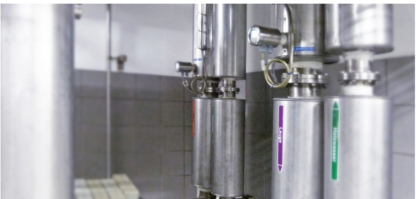
ILM-4 im CIP-Vor- und Rücklauf
