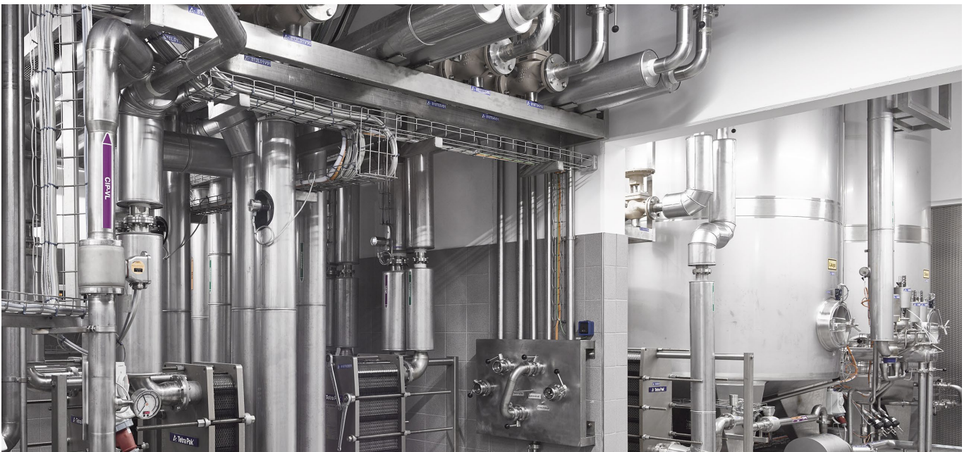
Die CIP-Anlage mit aktiver Phasentrennung durch Sensortechnik
