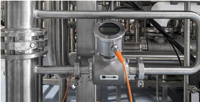
Pour le débitmètre FMQ également, un seul câble assure l'alimentation électrique et l'échange de données dans les deux sens. IO-Link permet de le surveiller, programmer et paramétrer via Internet.
