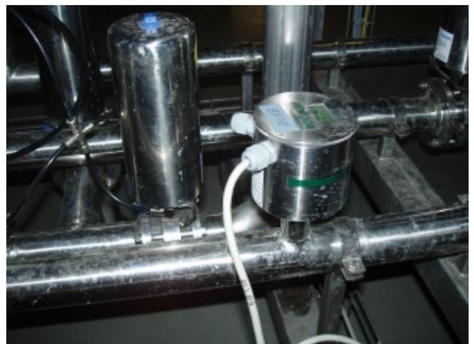
**Trübungsmessgerät ITM-2** zur Phasentrennung Milch - Wasser. Eingesetzt beim Leerfahren einer Produktionsanlage. Nach Beendigung der Produktion wird die Anlage mit Wasser leergeschoben. Mit dem ITM-2 wird genau bestimmt, wann die Anlage vollständig entleert ist.
