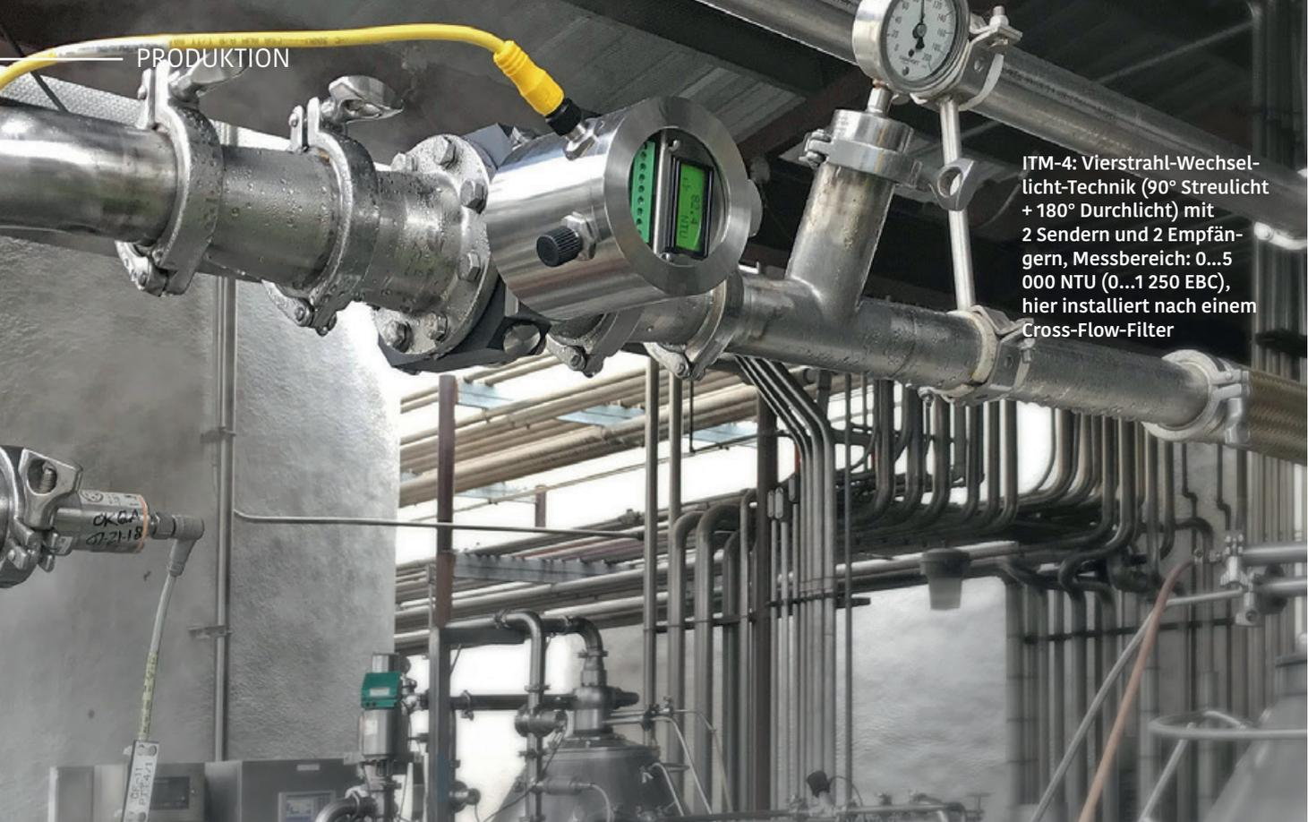
ITM-4: Vierstrahl-Wechsellicht-Technik (90° Streulicht + 180° Durchlicht) mit 2 Sendern und 2 Empfängern, Messbereich: 0...5 000 NTU (0...1 250 EBC), hier installiert nach einem Cross-Flow-Filter
