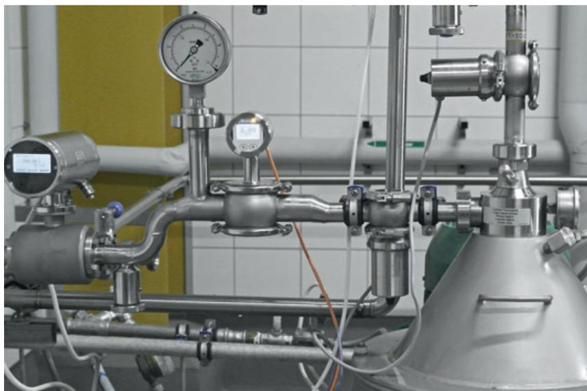
**ITM-51: Frontbündiger, kompakter Sensor, Messbereich 200...300.000 NTU (50...75.000 EBC), einfachste hygienische Installation (Clamp- oder Schraubanschluss), hier installiert in einem Separator**
