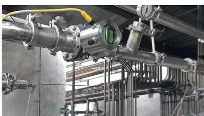
Vierstrahl-Wechsellicht-Sensor ITM-4 (90° Streulicht + 180° Durchlicht) mit 2 Sendern und 2 Empfängern, Messbereich: 0...5 000 NTU (0...1 250 EBC), hier installiert nach einem Cross-Flow-Filter.
