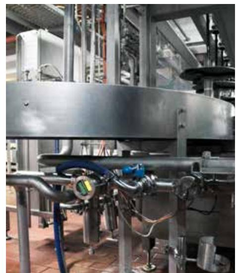
Индуктивный датчик проводимости в модульном исполнении
