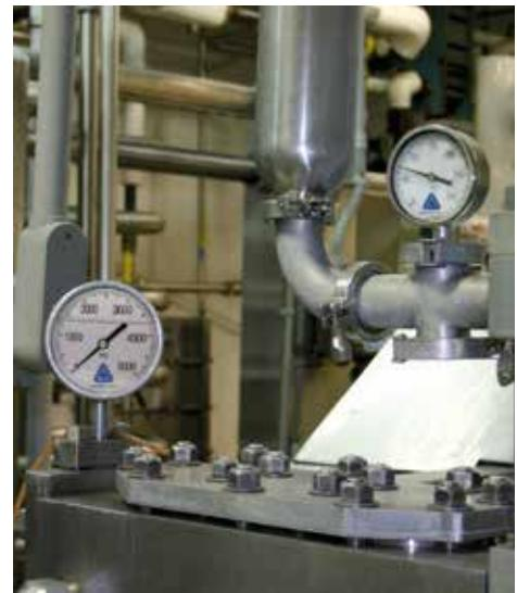
Манометр со встроенным передатчиком для гомогенизаторов
