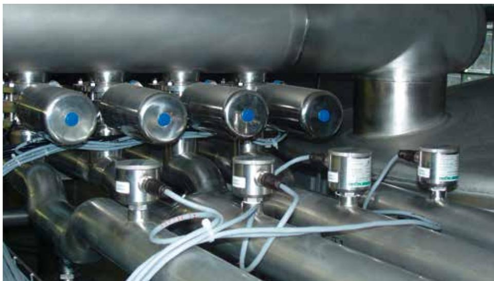
Измерение расхода деминерализованной воды
