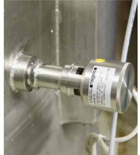
Устойчивый к воздействию температуры и агрессивных сред датчик уровня наполнения с гигиеническим соединительным разъемом CLEANadapt
