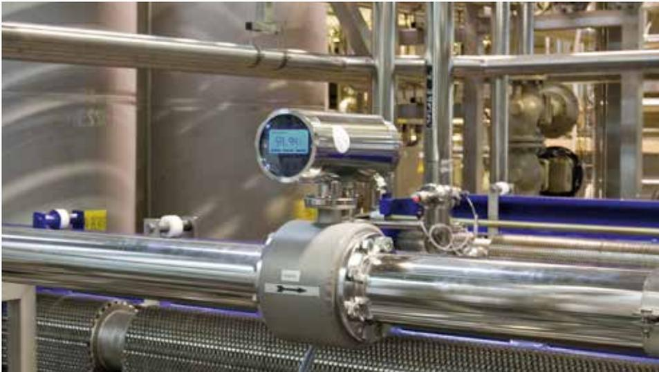
Измерение расхода деминерализованной воды
