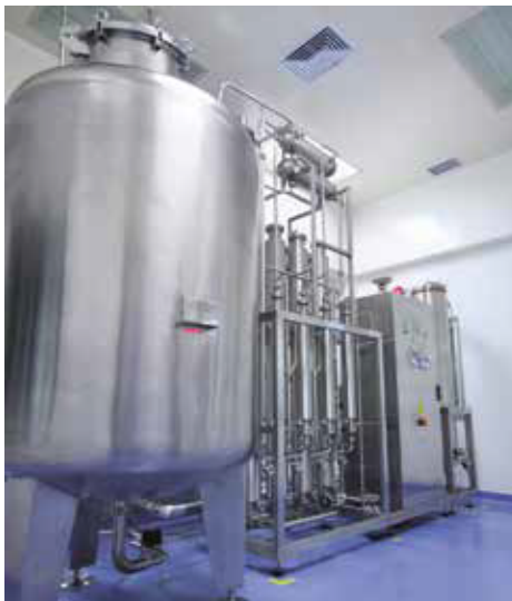
Medição de vazão de água desmineralizada
